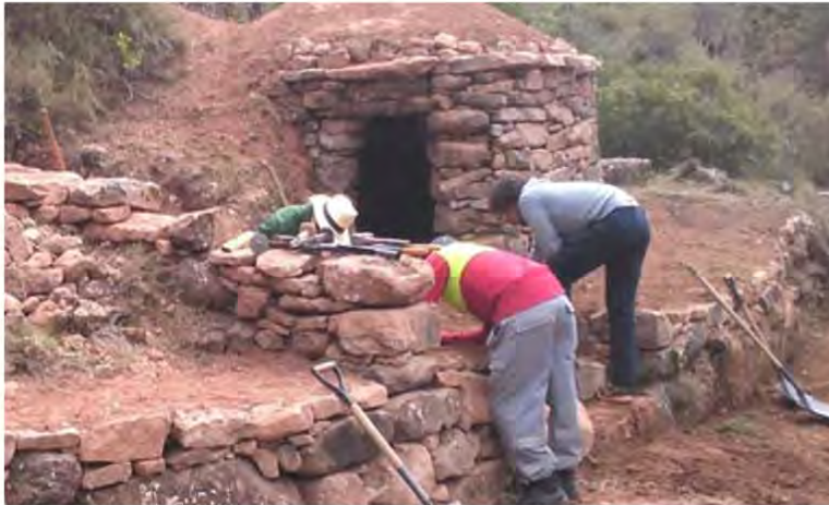
Imatge d'un curs de construccions de pedra seca / ARXIU PARTICULAR
